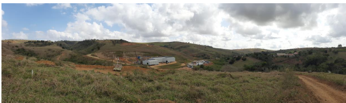
Foto 3-3: Vista panorâmica da ADA do empreendimento, trecho principal no qual está sendo instalado o projeto piloto.
