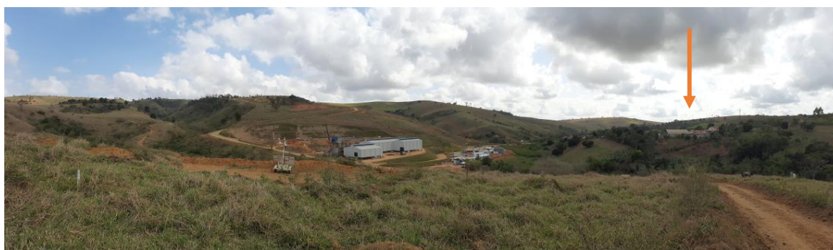
Foto 5-10: Visada a partir da ADA do empreendimento, local em que está sendo instalado o Projeto Piloto, sendo possível avistar um trecho de União Baiana, identificado por uma seta laranja.
