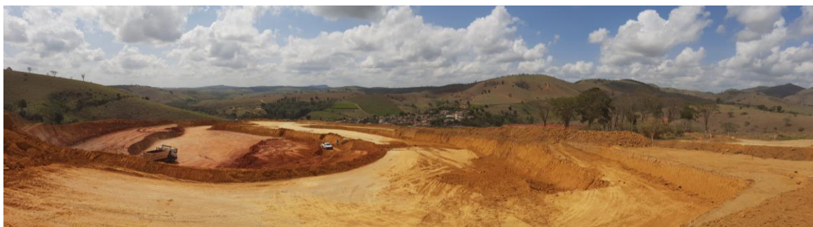
Foto 3-2: Vista panorâmica da ADA do empreendimento, trecho principal no qual está sendo instalado o projeto piloto. No centro ao fundo, núcleo urbano de União Baiana.
