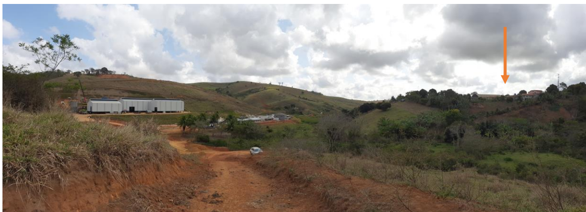
Foto 5-11: Visada a partir da ADA do empreendimento, local em que está sendo instalado o Projeto Piloto, sendo possível avistar um trecho de União Baiana, identificado por uma seta laranja.
