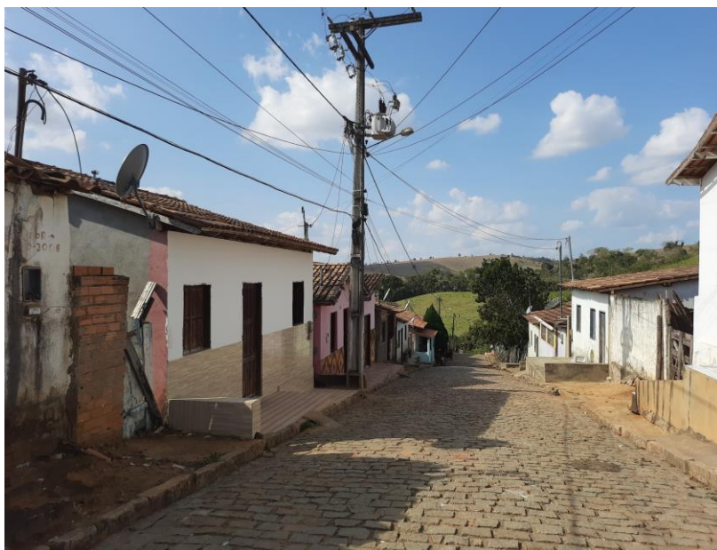
Foto 4-2: Vista do núcleo urbano de União Baiana, com predomínio dos imóveis térreos ou de dois pavimentos, implantados no alinhamento da via.
