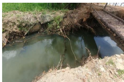
Figura 3-46 – Condição degradada do córrego Ribeira nas imediações da ADA por lançamento de efluentes domésticos.
