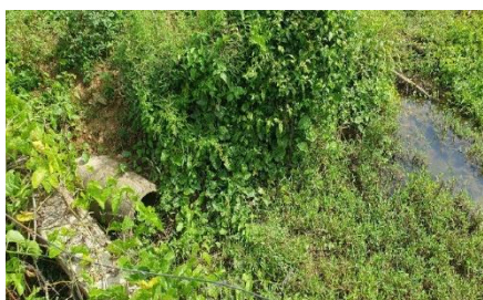
Figura 3-45 – Lançamento de efluentes domésticos de União Baiana diretamente no córrego Ribeira.
