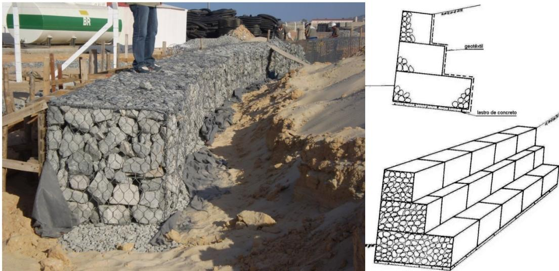
Figura 116: Muro de gabião comumente utilizado na contenção de processos erosivos.
